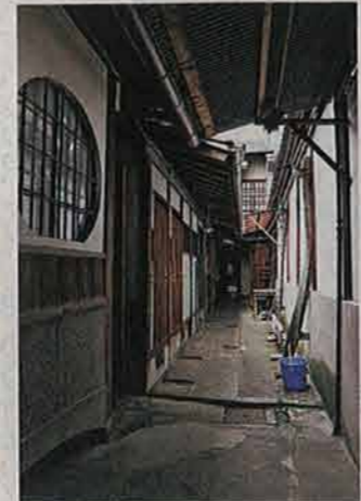
▶奥から見た通り庭(下)。店庭、玄関庭、走り庭を合わせて「通り庭」と呼ぶ
